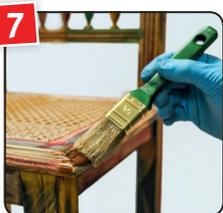
7 CLOU Holz-Siegel zu 20 % mit CLOU EV-Verdünnung verdünnen und die getrocknete Fläche grundieren.
