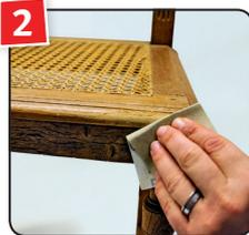
2 Fläche mit Körnung 120–150 anschleifen und entstauben.
