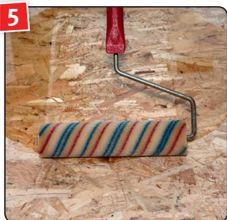
5 ... mit einer Versiegelungsrolle für Lösemittellacke gleichmäßig verteilen. Den Lack in mehreren Schichten auftragen.
