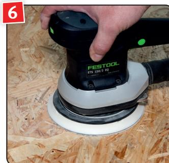
6 Die Fläche ca. 12 Std. trocknen lassen und mit Zwischenschliff Körnung 240–280 zwischenschleifen und entstauben.
