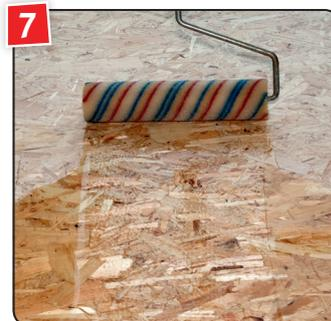
7 Die grundierte Fläche mit ca. 10% verdünntem OSB-Lack versiegeln und ausreichend trocknen lassen.
