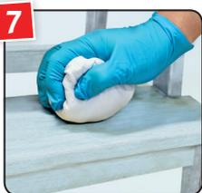
7 Nach ca. 20–30 Min. Trocknung, überschüssiges Hartöl mit einem sauberen Baumwolltuch vollständig entfernen und Fläche trockenpolieren. Über Nacht trocknen lassen.
