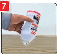
7 Für die Endlackierung CLOU Spraymat Nitro-Lack mit dem Kopf nach unten ca. 2 Min. kräftig schütteln ...
