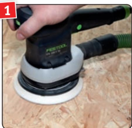
1 Die Oberfläche muss frei sein von Schmutz-, Wachs-, Öl- und Fettresten. Die Fläche in Holzstrukturrichtung mit Körnung 150–180 abschleifen und entstauben.
