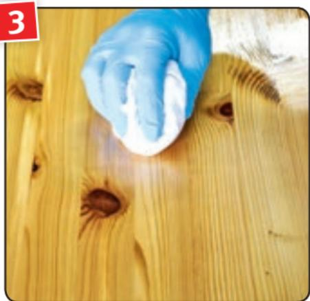
Überschüssiges Öl mit einem sauberen Baumwolltuch vollständig abnehmen, trocken polieren und die Fläche über Nacht trocknen lassen. Es darf kein Ölrest zurückbleiben.
