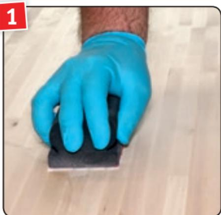
**1** Zu renovierende Oberfläche in Holzstrukturrichtung mit Körnung 180 anschleifen und entstauben.
