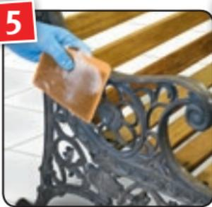
Die abgebeizte Fläche gründlich mit Wasser und einem Schwamm reinigen und vor der weiteren Verarbeitung mit Metalllacken gut trocknen lassen.
