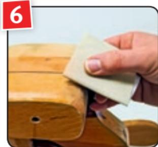
Nach 2–3 Std. Trocknung den Holzpaste-Überstand mit Körnung 120 planschleifen.
