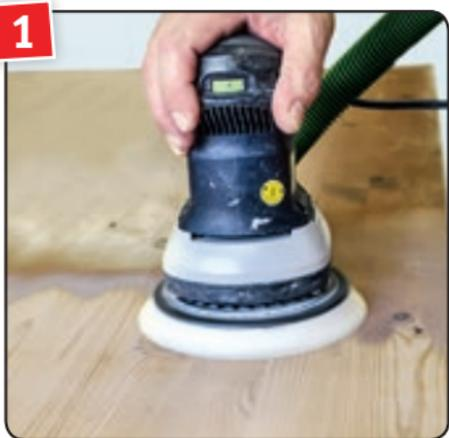
**1** Tischplatte säubern und Altanstriche mit Körnung 120–150 abschleifen und entstauben. Schleifarbeiten und Ölauftrag immer in Richtung der Holzstruktur durchführen.
