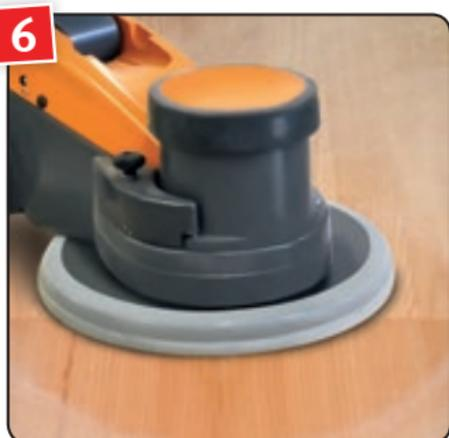
Die Fläche mit Zwischenschliff Körnung 120 und dem gebrauchten Schleifgitter vom vorherigen Endschliff nochmals anschleifen und entstauben.
