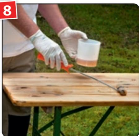
Für strapazierfähige Oberflächen einen zweiten Auftrag mit verdünntem Holz-Siegel vornehmen. Fläche über Nacht trocknen lassen.
