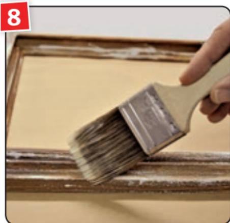
**8** Zum Schluss den Bilderrahmen mit AQUA CLOU Holzlack in seidenmatt lackieren und über Nacht gut trocknen lassen.
