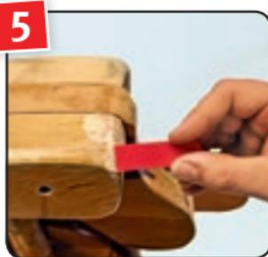
Holzpaste mit dem Spachtel in die Schadstelle einarbeiten, so dass sich die Risse mit Holzpaste füllen. Vorher testen ob die Farbtöne von Holzpaste und Endlackierung zusammen passen.
