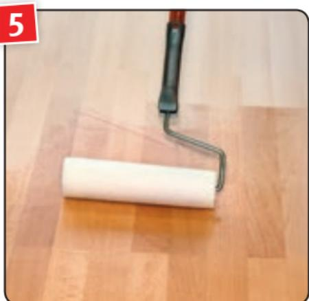
Zügig Bahn für Bahn in Längsrichtung vom Fenster weg arbeiten und Fläche über Nacht trocknen lassen. Während Verarbeitung und Trocknung Fläche vor Sonneneinstrahlung schützen.
