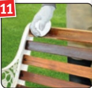
Das überschüssige Öl nach 10 min. mit einem sauberen Baumwolltuch abnehmen. Nach Trocknung über Nacht und einem Zwischenschliff den Auftrag mit einem Schleifvlies wiederholen.
