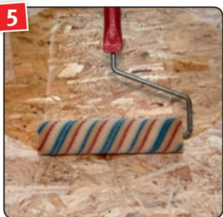
5 ... mit einer Versiegelungsrolle für Lösemittellacke gleichmäßig verteilen. Den Lack in mehreren Schichten auftragen.
