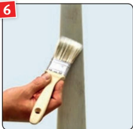
**6** AQUA CLOU Wachslasur mit einem Pinsel gleichmäßig und nicht zu satt in Holzstrukturrichtung auftragen. Wachslasur-Überschuss gleichmäßig verteilen.
