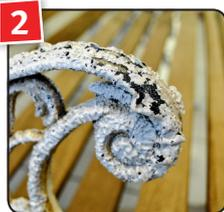
**2** Lack-Abbeizer 1–2 Std. einwirken lassen bis Krusten oder Blasen entstehen. Bei mehrlagigen Schichten sind unter Umständen zwei Arbeitsgänge notwendig.
