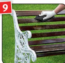
**9** Nach Trocknung über Nacht die Fläche mit einem Schleifvlies anschleifen und entstauben.
