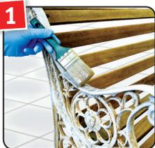
**1** CLOU Lack-Abbeizer unverdünnt mit Pinsel oder Spachtel mind. 1 mm dick auftragen. Beim Verarbeiten Schutzbrille, Handschuhe tragen und für gute Belüftung sorgen oder im Freien arbeiten.
